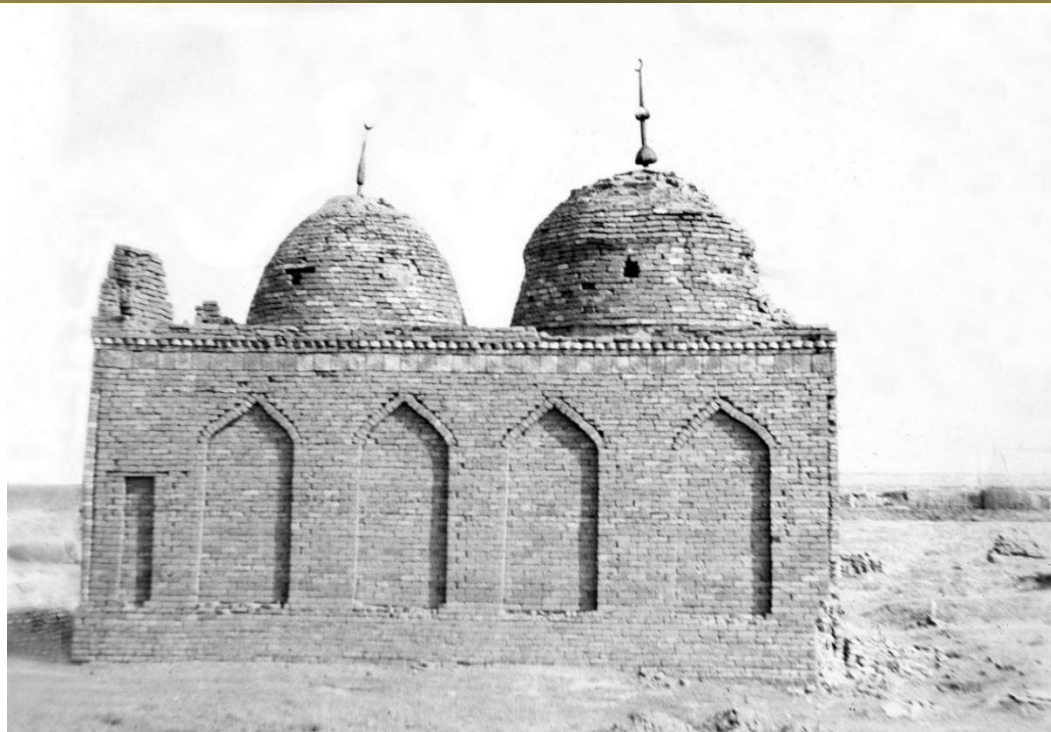
Рис. 4. Двухкамерный мавзолей Сатыпалды ишана (Қоржынтам) [Fig. 4. Two-chamber mausoleum of Satypaldy Ishan (Korzhyntam)]
