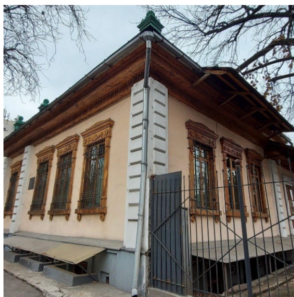
Сурет 4 – Зенковтар сәулетшілер үйінің қазіргі бейнесі [Fig. 4 – The current appearance of the Zenkov Architects' House]
